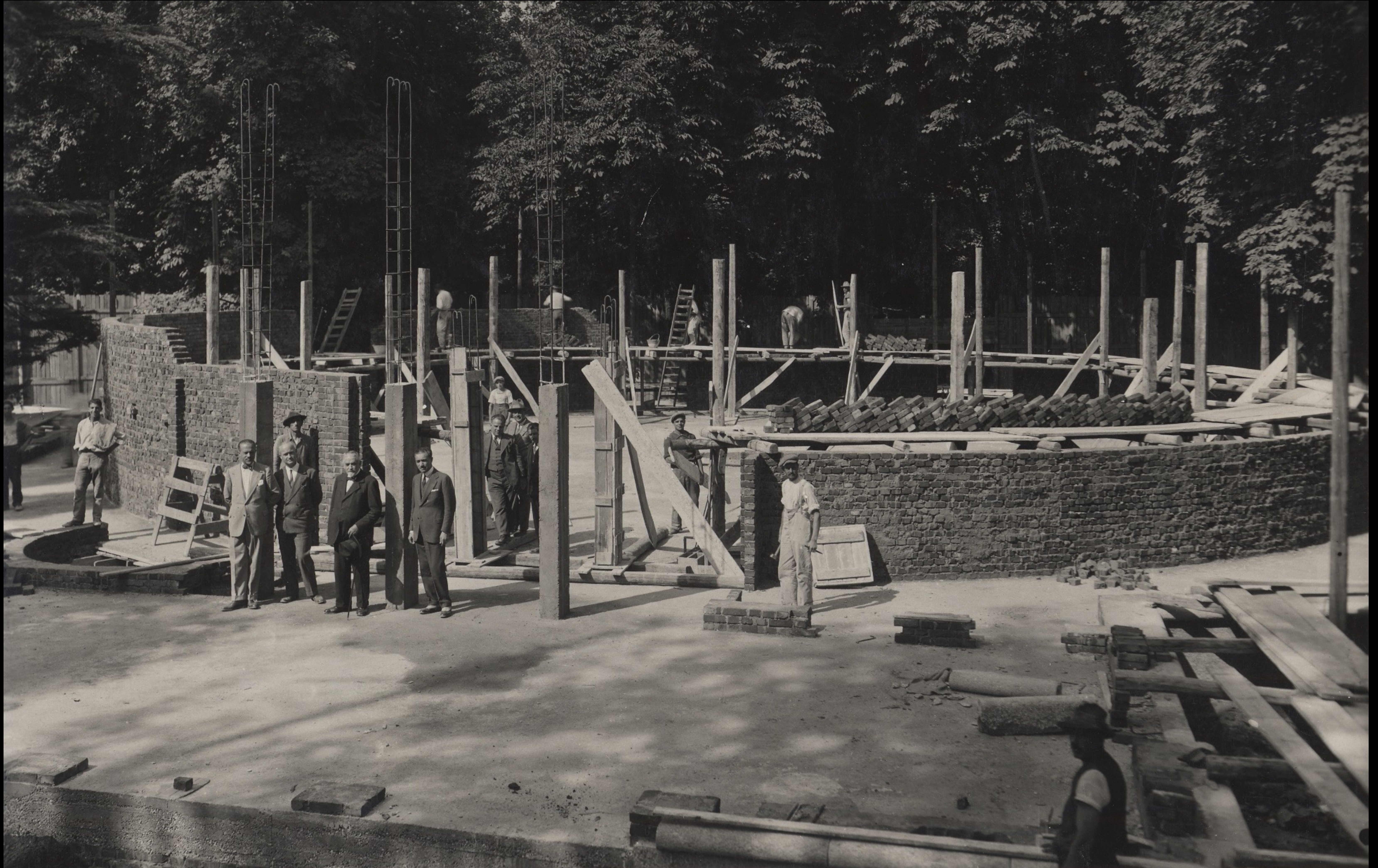
La costruzione del Planetario Ulrico Hoepli di Milano (19 settembre 1929). L'immagine è stata scattata dal fotografo Antonio Paoletti. Fondazione Piero Portaluppi, Milano; per gentile concessione.
